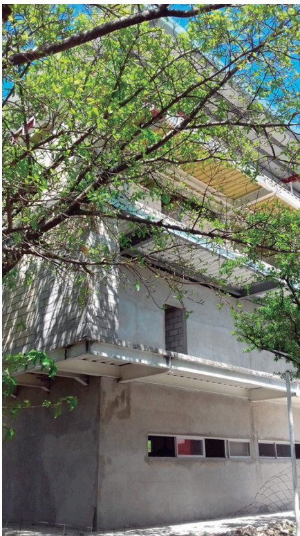
Foto 5.5 Fachada principal del edificio
