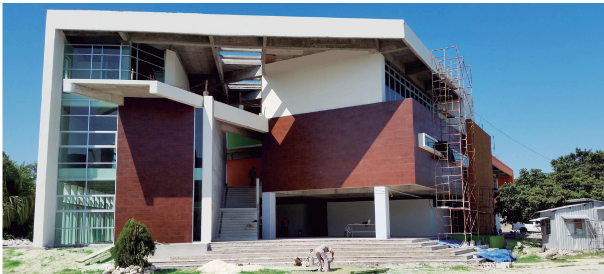
Foto 5.7 Fachada principal del edificio
