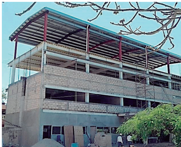
Foto 5.6 Fachada posterior del edificio
