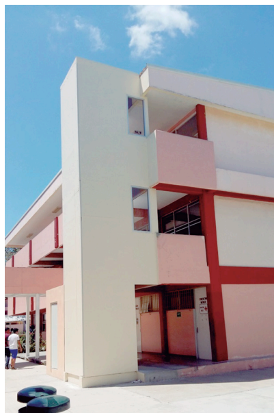
Foto 5.4 Elevador del Edificio “D”
