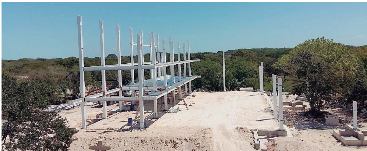
Foto 5.9 Construcción de la estructura del edificio
