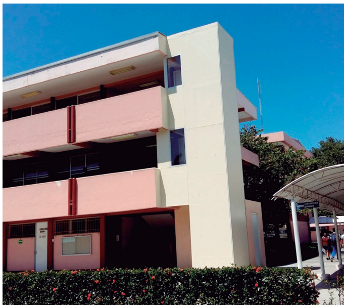
Foto 5.2 Elevador del Edificio “E”
