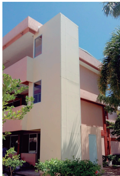
Foto 5.3 Elevador del Edificio “C”
