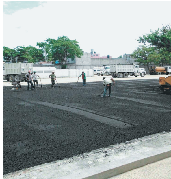
Foto 5.11. Estacionamiento del edificio de vinculación
