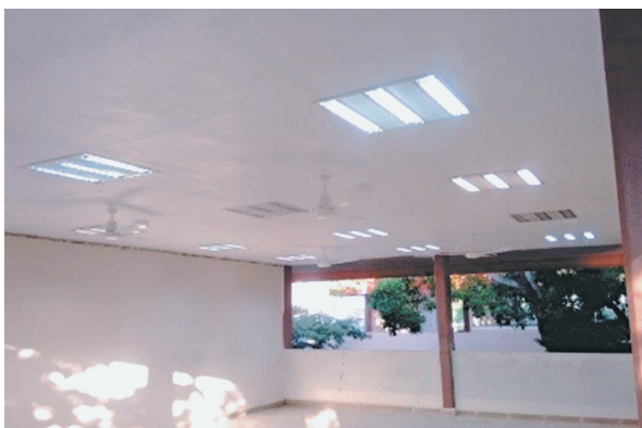
Foto 5.4. Segundo Nivel de Los Edificios “U” y “V” y Dos Conexiones
