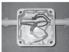
Empalme incorrecto: se trenzan los cables y se los empalma con cinta aislante. Esto es del todo incorrecto, ya que puede llegar a deteriorarse la cinta, separarse los conductores y provocar un incendio.
